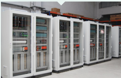
لوحات التحكم بوحدات التحكم المنطقية القابلة للبرمجة (PLC)
